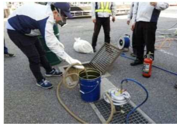
エアポンプを用いて汚水回収
