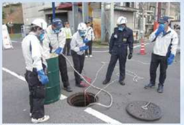
エアポンプを使用してマンホール内から汲み出し
