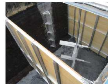
脱窒工程追加で改造が完了した脱窒槽
