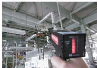
エア漏れ検知器 (エア漏れ箇所にレベルゲージが反応)
