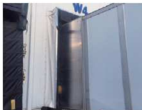
トラックヤードに設置したプラットフォームカバー
